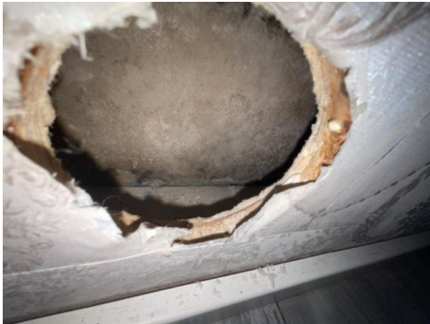
Fuktskjolder inv. i hulltagning
