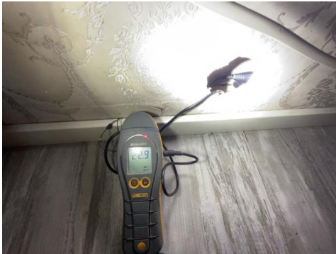
Fuktmåling i hulltagning
