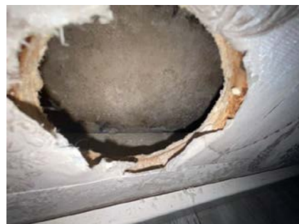
Fuktskjolder inv. i hulltagning
