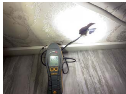
Fuktmåling i hulltagning
