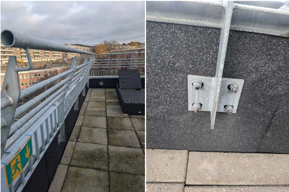
Bildene over viser Rekkverk og innfesting. Rekkverkene er skrudd direkte gjennom membranen.
