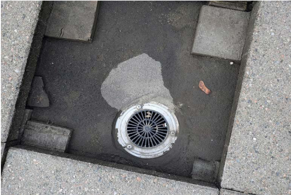
Bilde over viser sluk.
