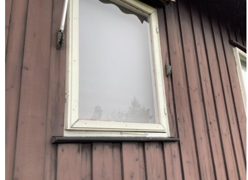
Vindu i første etasje provisorisk utbedret ved utvendig pålekting.
