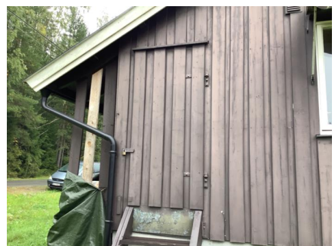
Enkel dør til bod. Tilkost via provisorisk tretrapp.
