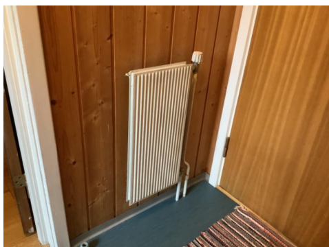
Eldre røropplegg og tilknyttede radiatorer i boligens første etasje.
