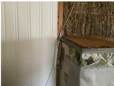
Ledninger som ikke er tilstrekkelig festet og bruk av skjøtekabel.
