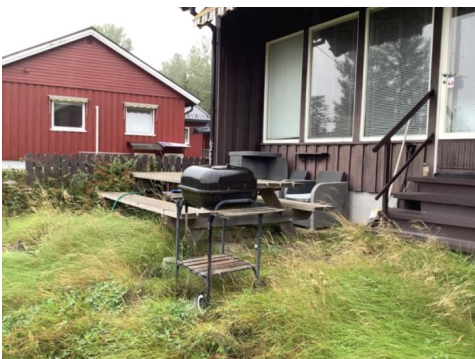
Gjengrodd, ujevnheter i heller god etterslep på vedlikehold.
