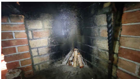
Kontroll av ildsted.
