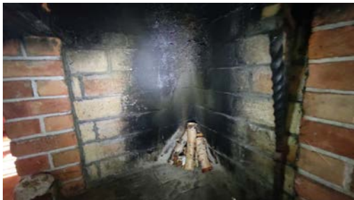
Kontroll av ildsted.
