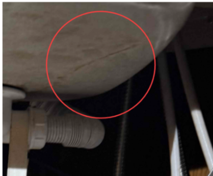
Bildet viser sprekk i oppvaskkum.
