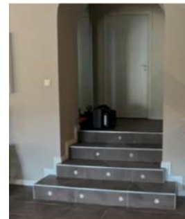
Bildet viser trapp mellom kjøkken og gang.
