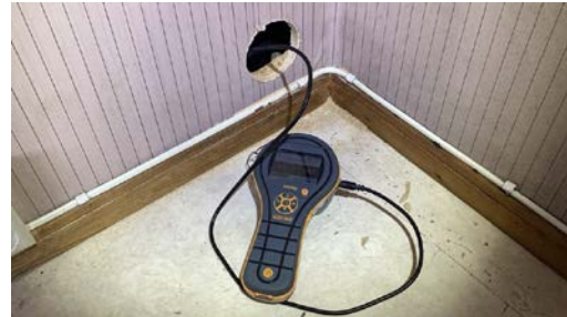
Fuktmåling ble foretatt, jeg målte tørre verdier i konstruksjon.
