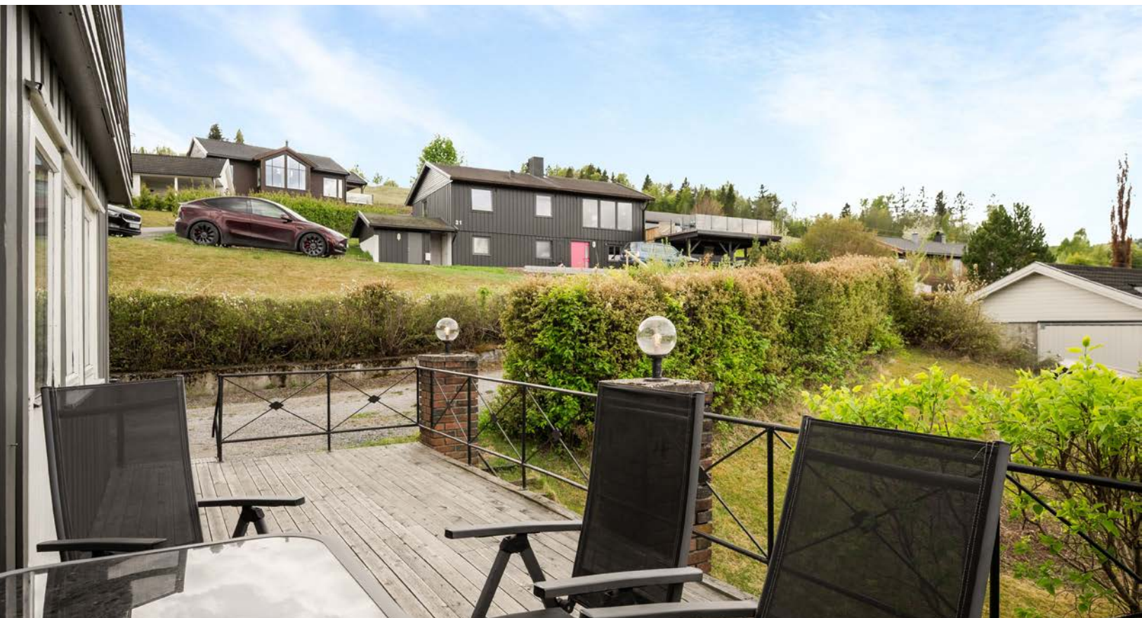
Terrassen er fundamentert med solide konstruksjoner i tre og metall.
