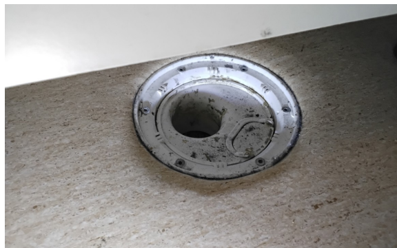
Sluk på vaskerommet
