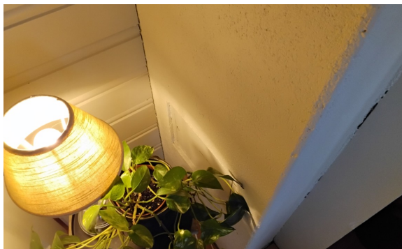
Bilde av sotluke
