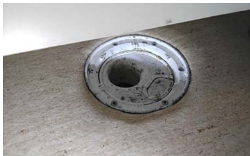
Sluk på vaskerommet
