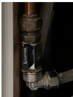
Vannrør med Balofix stoppekrane i gang.
