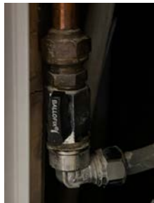
Vannrør med Balofix stoppekran i gang.
