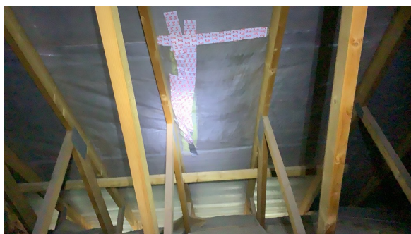
Skade i eldre undertaksduk er reparert.
