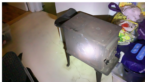
Eldre vedovn er montert i kjelleretasje.
