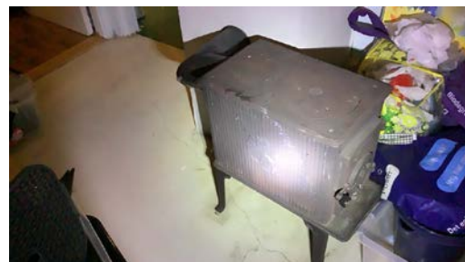
Ubrennbar plate foran ovn er for kort. Kravet er 30 cm utenfor Eldre vedovn er montert i kjelleretasje. brannkammer.
