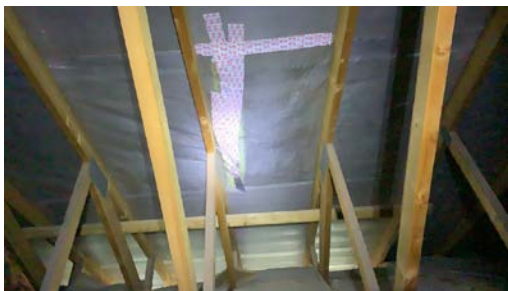
Skade i eldre undertaksduk er reparert.
