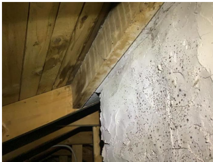
Bildene viser fuktskjolder.
