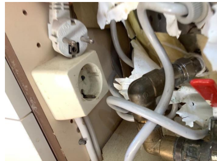
Bildet viser utilfredsstillende el-tilkobling iht. gjeldende forskrift.
