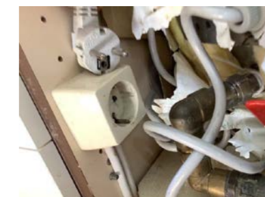
Bildet viser utilfredsstillende el-tilkobling iht. gjeldende forskrift.
