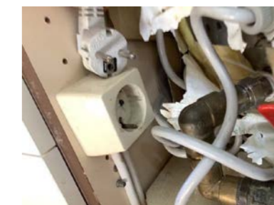
Bildet viser utilfredsstillende el-tilkobling iht. gjeldende forskrift.
