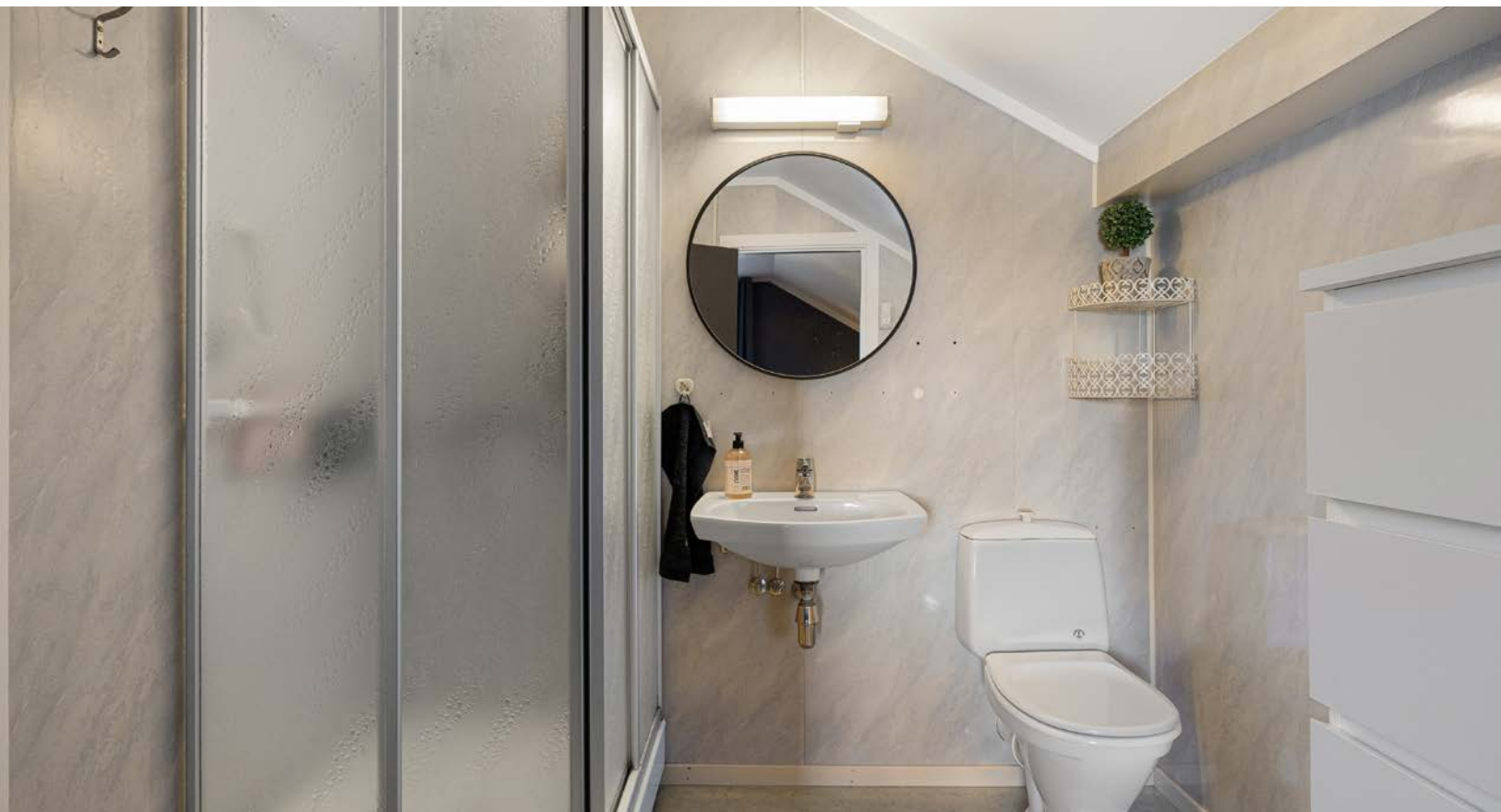
Badet i 2. etasje har lyse våtromsplater på veggene og grått belegg på gulv med sluk. I tillegg til et toalett har badet en vegghengt servant, speil, belysning og dusjkabinett.
