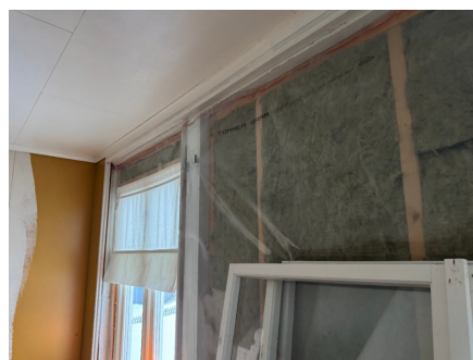
Ikke kledd vegger innvendig i gang der det er trapp til loft
