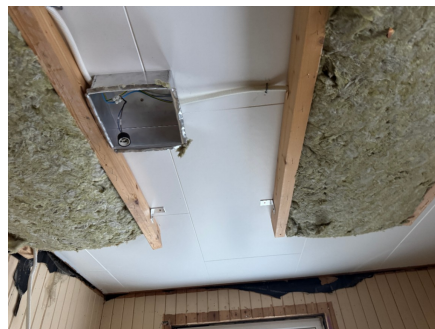
Påbegyndt nedlekting av himling på ett soverom
