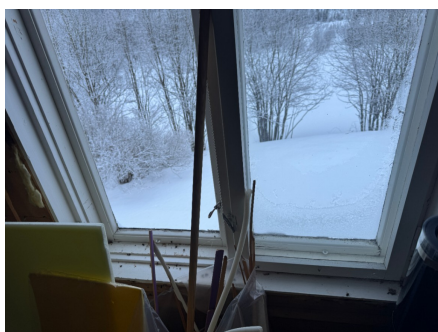
Gammel vindu på soverom under oppussing
