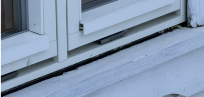
Glippe mellom vindu og beslag under
