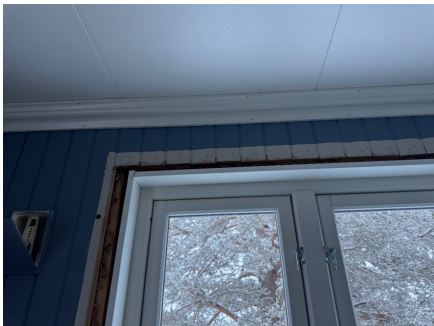
Glippe mellom vindu og beslag under
