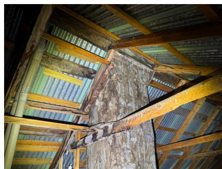
Bekktutslag på pipe
