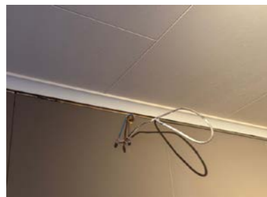
Midlertidig åpent el. punkt grunnet oppussing
