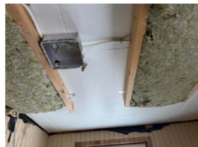
Påbegyndt nedlekting av himling på ett soverom
