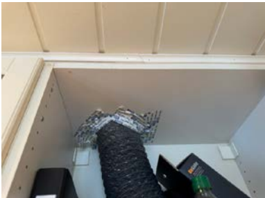
Tapet gjennomføring i skap
