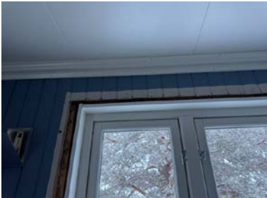
Glippe mellom vindu og beslag under
