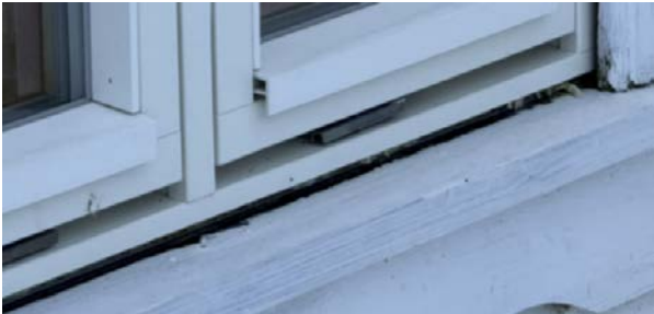
Glippe mellom vindu og beslag under
