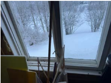
Gammel vindu på soverom under oppussing
