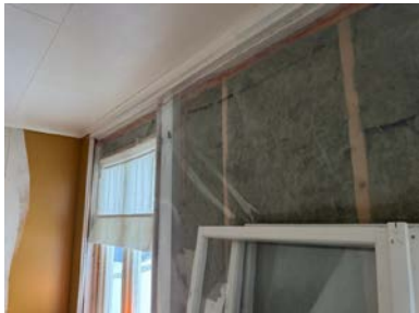
Ikke kledd vegger innvendig i gang der det er trapp til loft
