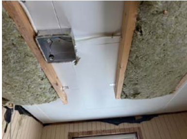
Påbegyndt nedlekting av himling på ett soverom
