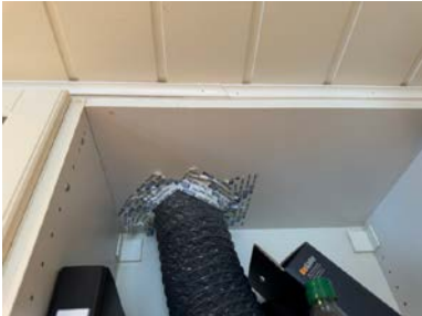
Tapet gjennomføring i skap
