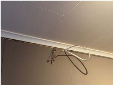
Midlertidig åpent el. punkt grunnet oppussing
