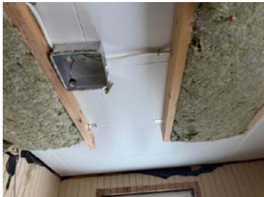
Påbegyndt nedlekting av himling på ett soverom
