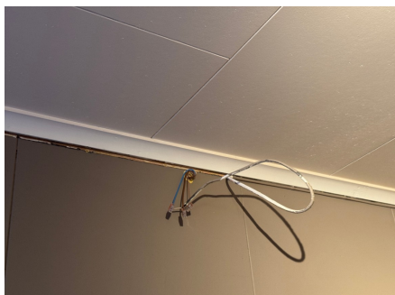
Midlertidig åpent el. punkt grunnet oppussing
