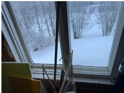
Gammel vindu på soverom under oppussing
