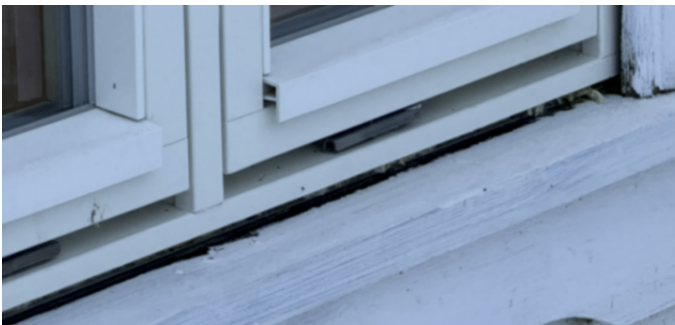
Glippe mellom vindu og beslag under
