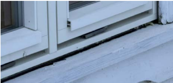
Glippe mellom vindu og beslag under
