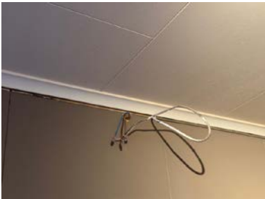
Midlertidig åpent el. punkt grunnet oppussing
