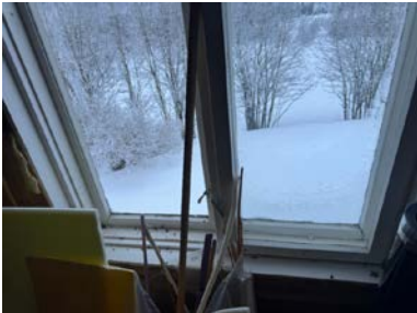
Gammel vindu på soverom under oppussing
