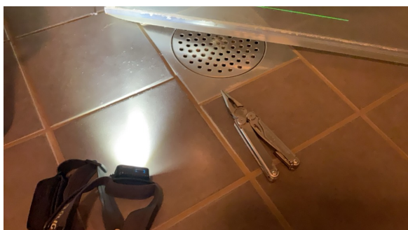
Kontroll av sluk.
