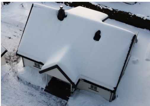
Bilde av snødekt tak
