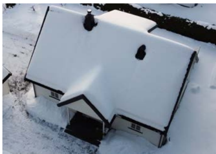
Bilde av snødekt tak
