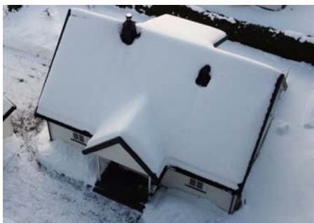
Bilde av snødekt tak
