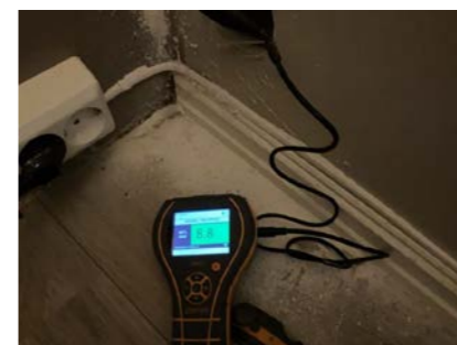
Fuktmåling i konstruksjon i yttervegg under terreng.
