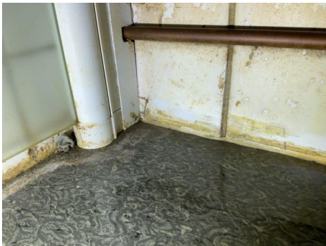
Knekte fliser i våtsonen i dusjen.
