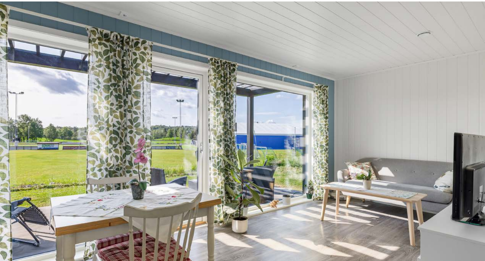
På gulvet er det laminat og veggene har malte MDF-plater.
