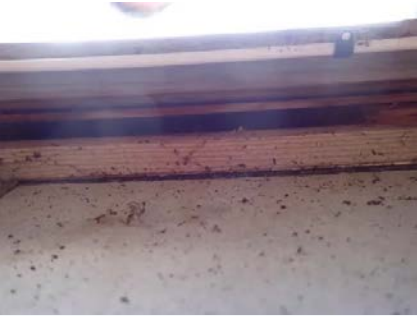
Åpning stor nok til at mus kan trenge inn.
