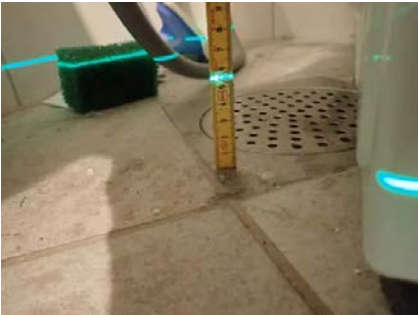
Referansenivå laser = 50 mm. Viser høydeforskjell til topp membran under flis ved dør på ca. 5 mm.
