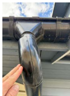
Bildet viser tappestykke på takrenne med åpning.
