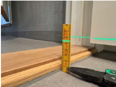
Fall mot sluk er målt med laser, målt fra gulv ved dør.
