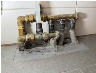
Rørgjennomføringer i gulv under servant.
