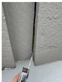
Belistning ligger helt ned til vannbrettbeslag.
