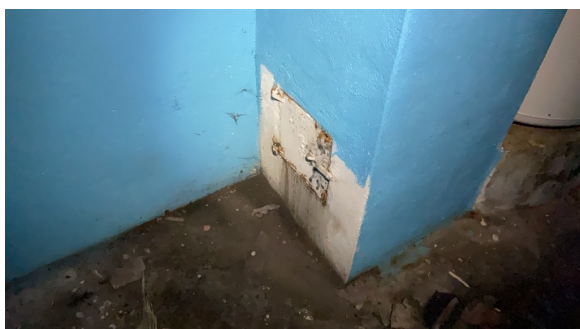
Sotluke plassert i kjeller.
