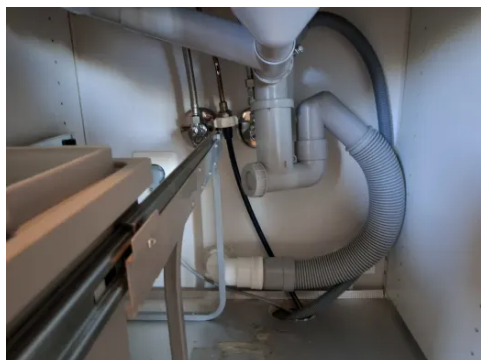
Leiligheten har synlige avløpsrør av plast.
