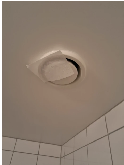
Avtrekkseffekt er testet med papir.
