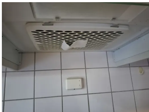
Avtrekkseffekt er testet med papir.
