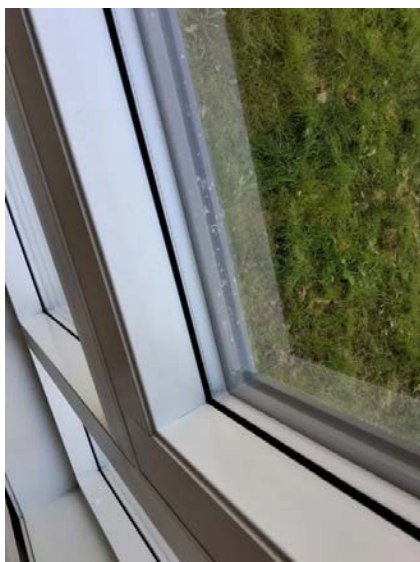
Hovedparten av vinduer i leiligheten har vinduer med to-lags glass.
