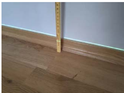
Etasjeskillet er kontrollert med nivelleringslaser.
