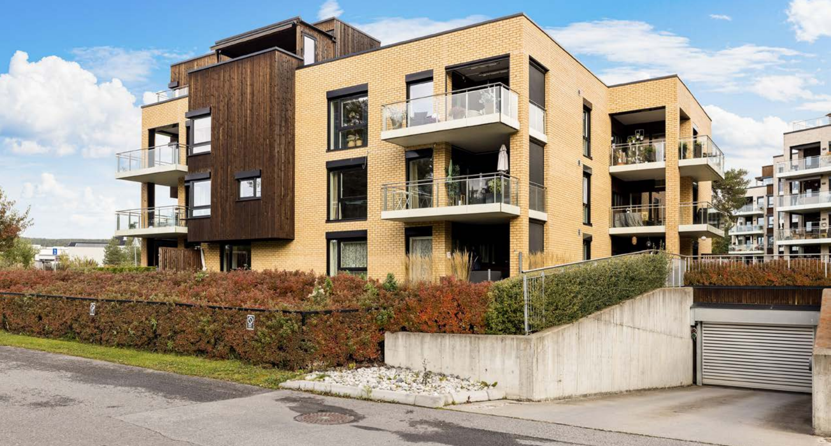
Det er parkeringskjeller under bygget.
