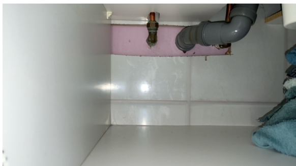
Mangelfull/feil utførelse rundt rørgjennomføringer
