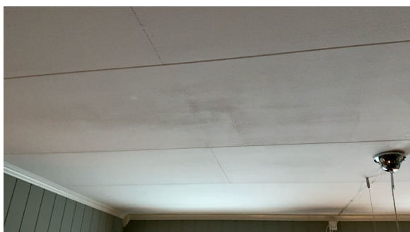
Maling skjolder i stuetak
