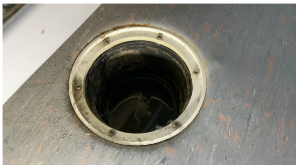
Mangelfull/feil utførelse rundt rørgjennomføringer
