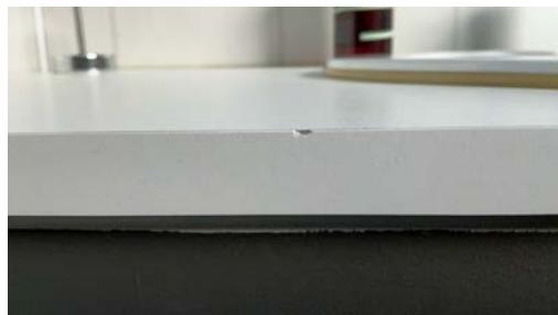
Hakk i platen
