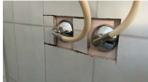
Hull i baderomsplate bak dusjkabinett
