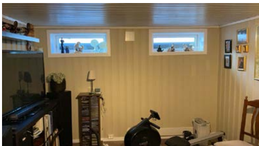
Vinduene i kjellerstuen er høyt oppe på veggen, samt at de er for små for rømming.
