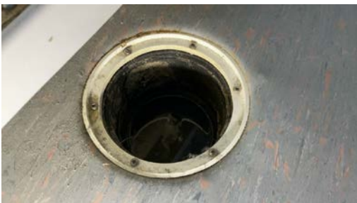
Mangelfull/feil utførelse rundt rørgjennomføringer
