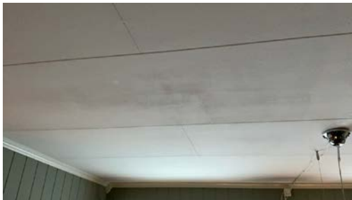
Maling skjolder i stuetak
