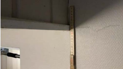
Fri høyde på ca 1,9m (litt under kravet på
