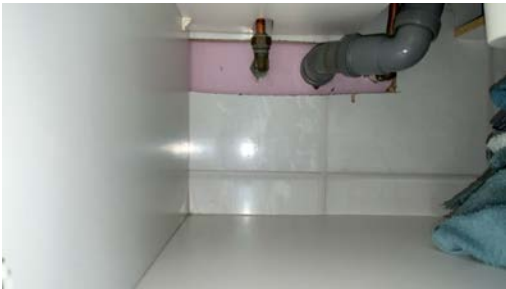
Mangelfull/feil utførelse rundt rørgjennomføringer
