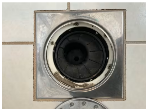
Viser sluk i dusjsonen.
