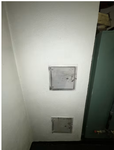
Viser sotluker i kjeller.
