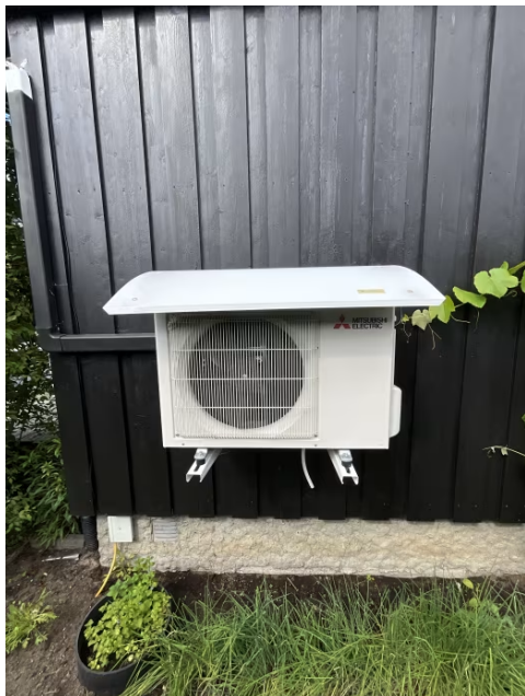
Viser utedel montert på sørvegg.
