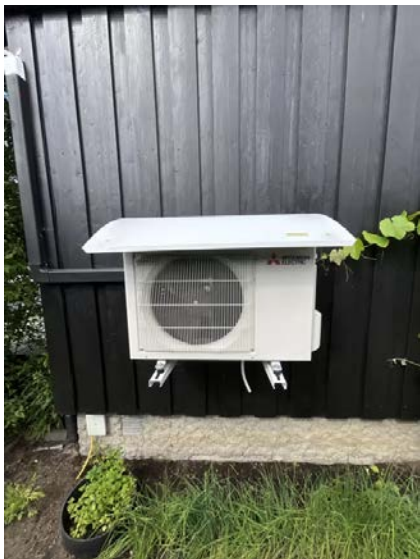
Viser utedel montert på sørvegg.
