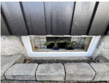
Det er ikke etablert beslag under bunnkarm på vinduer montert i mur.
