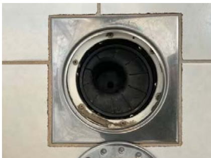
Viser sluk i dusjsonen.
