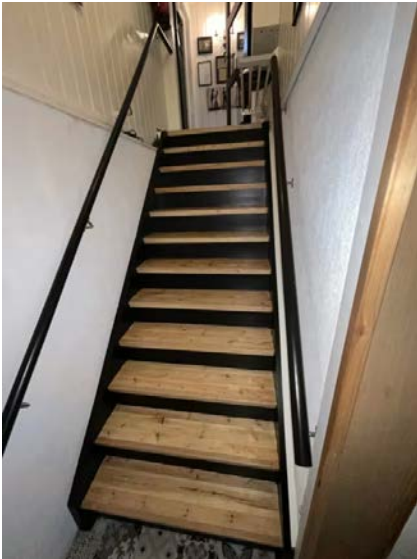
Viser trapp mellom etasjene.
