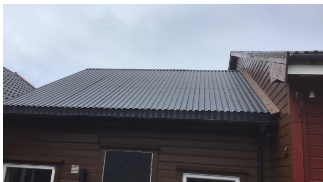
Plater på tak over mellombygg
