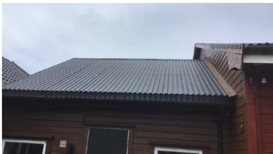
Plater på tak over mellombygg
