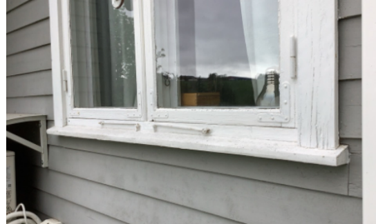
Vinduer med 1+1-lags glass fra byggeår.
