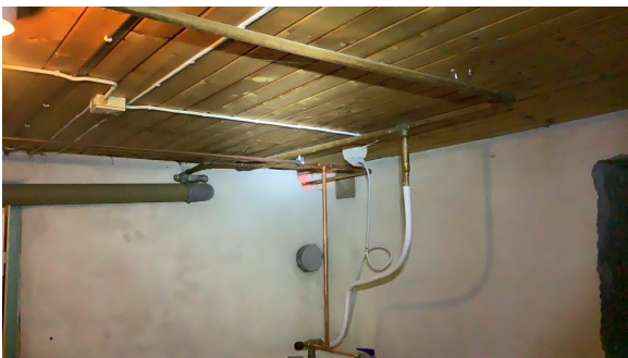
Vannrør av kobber.
