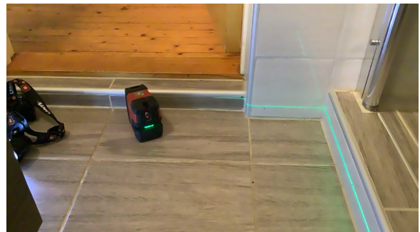
Det er terskel opp til dusjrom.
