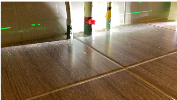
Eldre gjennomføringer i gulv.
