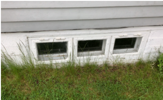
Vinduer med 1+1-lags glass fra byggeår.
