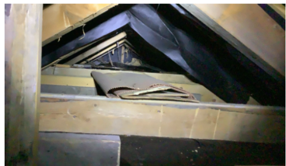
Begrenset tilgang på møneloft. Møneloftet er ikke isolert.
