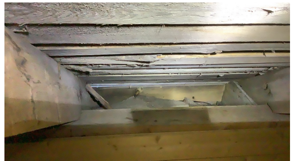
Isolasjon dekker lufting fra skråtak.
