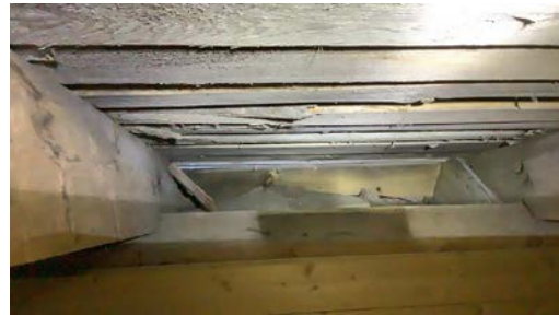
Isolasjon dekker lufting fra skråtak.
