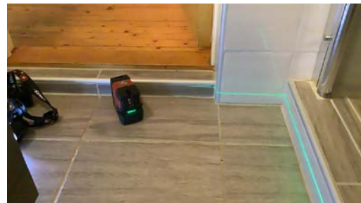
Det er terskel opp til dusjrom.
