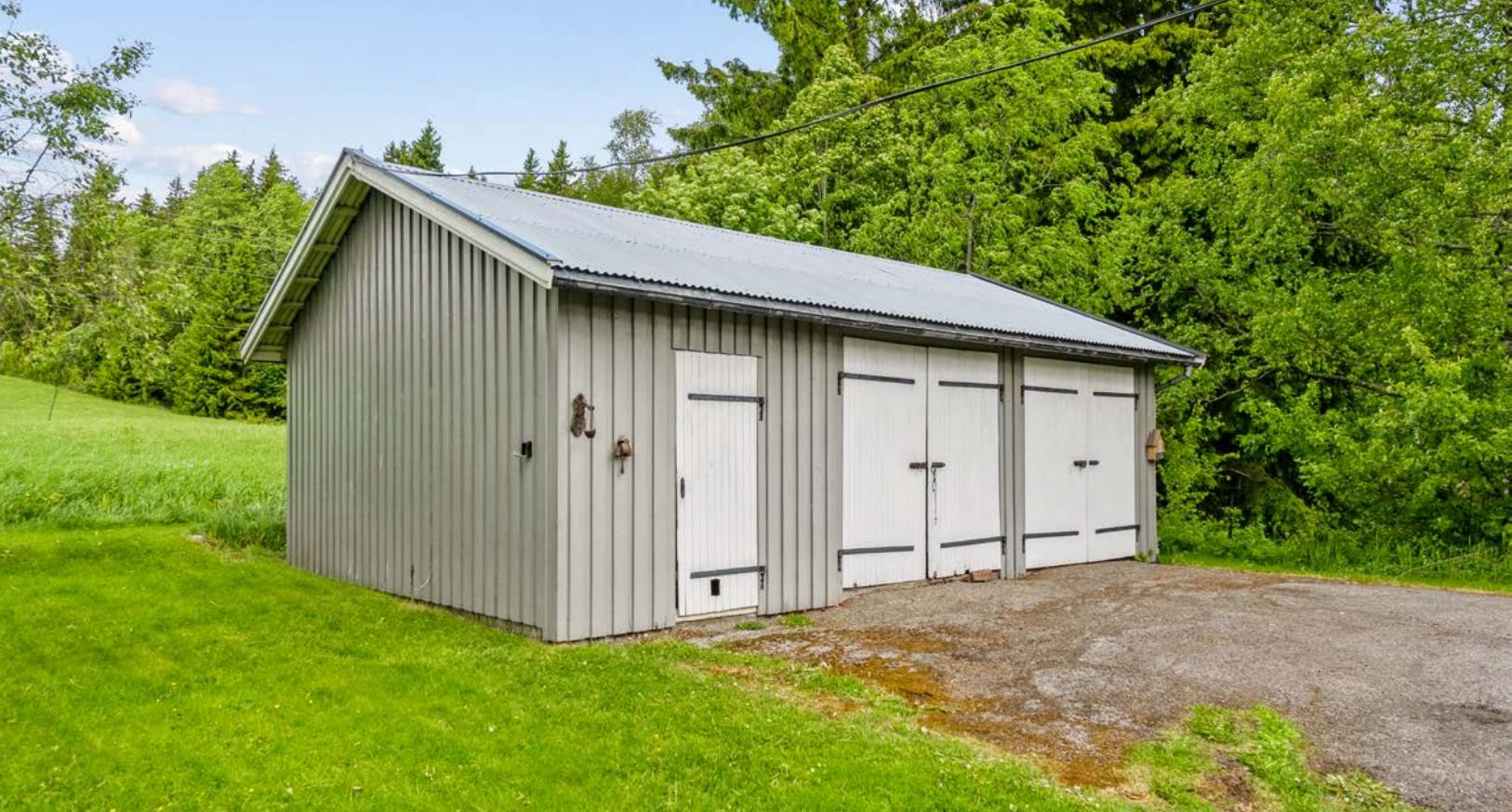
Garasje/ uthus på eiendommen.
