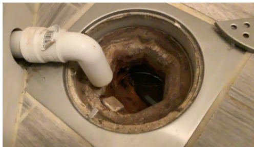
Eldre støpejernssluk på gulvet. Det er laget et lite tilførselsluk fra dusjenisje som renner opp i dette.
