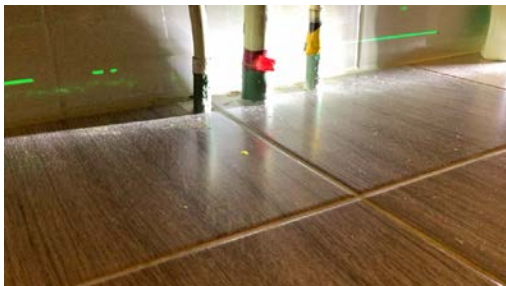
Eldre gjennomføringer i gulv.
