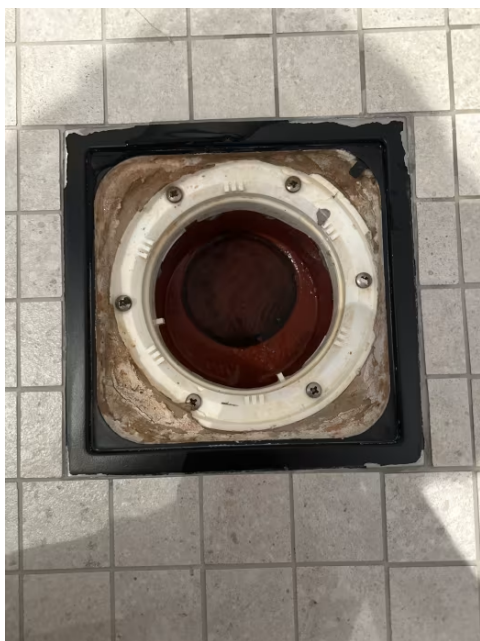
Viser sluk i dusjsonen.
