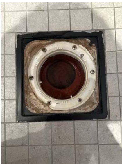
Viser sluk i dusjsonen.
